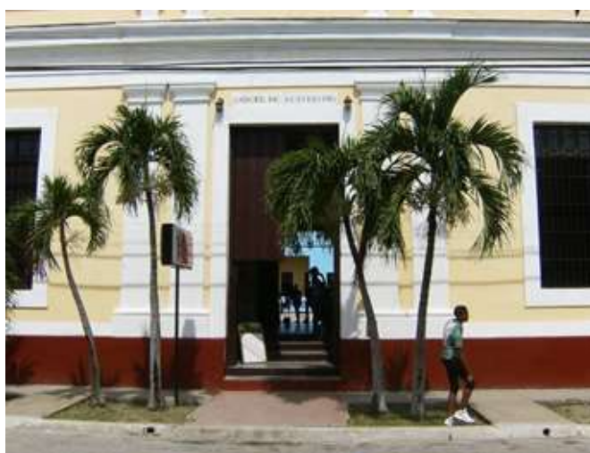
Fotografía 11. Vista exterior del MPG, 2014
