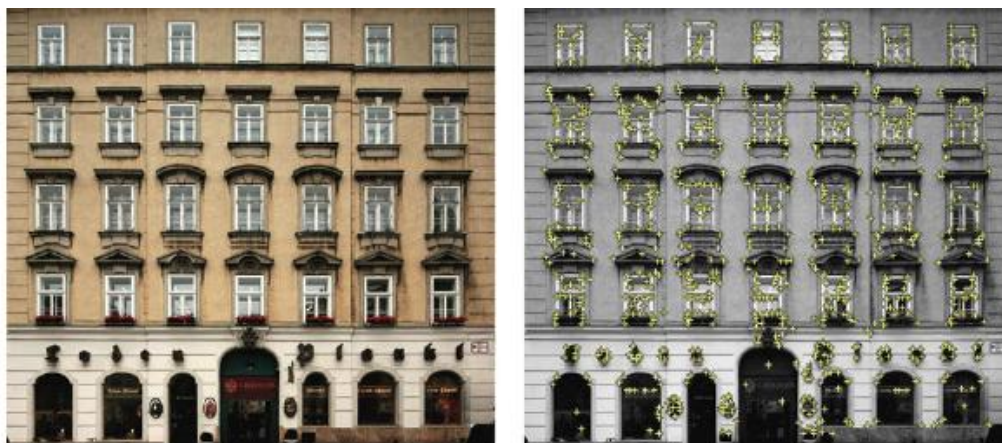
Figura 5. Reconhecimento de Fachada de um edifício.
