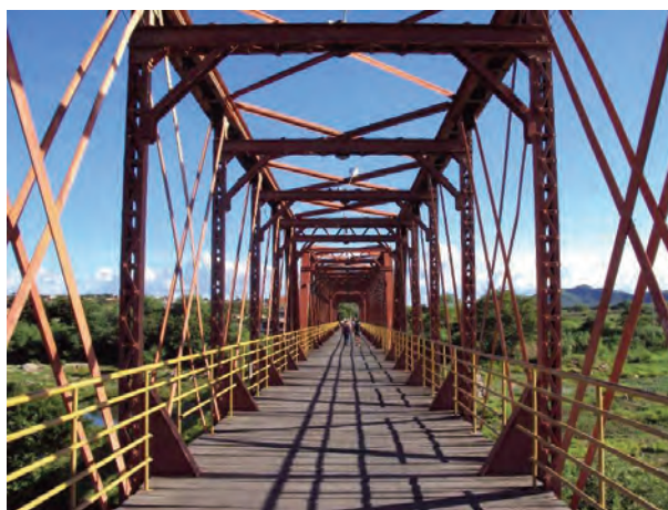
Figura 158. Ponte sobre rio em Quixeramobim (Fonte: Zanettini Arqueologia, 2010).
