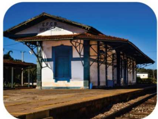
Estação Ferroviária de Brumadinho
