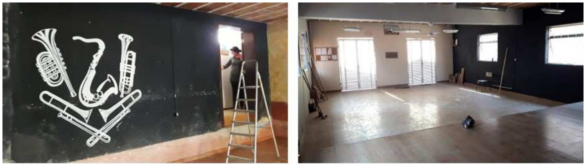
Figura 82. Sede da Cooperação Musical São Sebastião, em reforma, Brumadinho, 2017.
