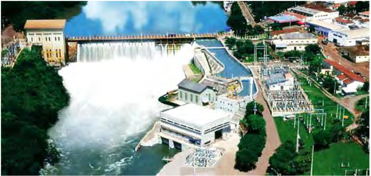
Figura 39. Instalações da usina Paranapanema, parte da Zona de Aproveitamento Hidrelétrico, encravada na Zona Urbana de Piraju [imagem: Prefeitura Municipal].
