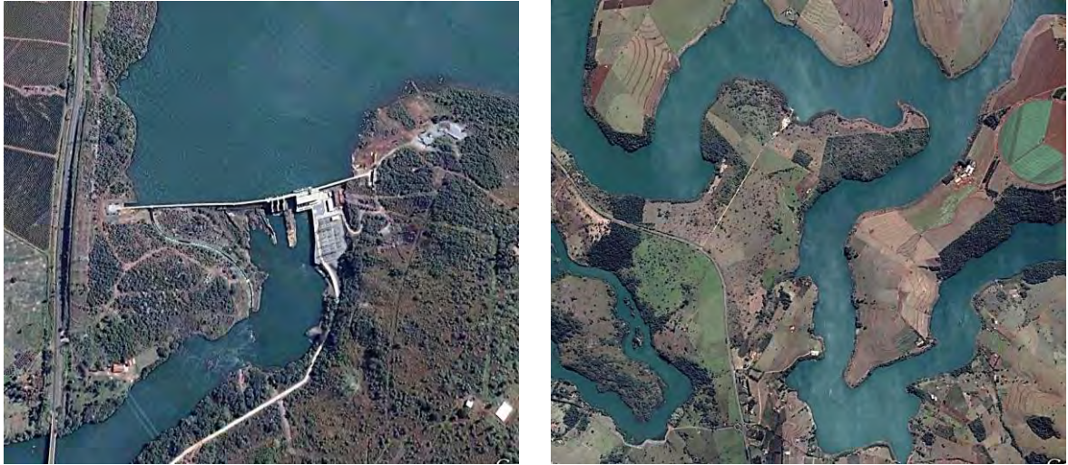
Figura 23. UP 2 Represas; barragem e trecho do reservatório da usina hidrelétrica Piraju (imagem Google Earth).
