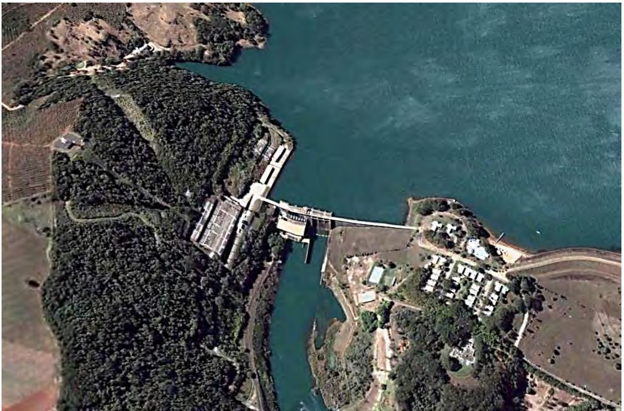
Figura 24. UP 2 Represas; barragem da usina Jurumirim (imagem Google Earth).
