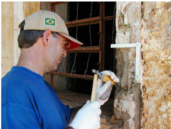
Figura 63. Pequenas intervenções para a coleta de amostras e leitura da edificação como documento arqueológico (cota positiva).
