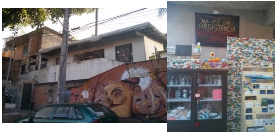
Imagem 24 - Vista externa do prédio do Muquifu em Belo Horizonte à esquerda e, à direita, a lojinha do museu na chegada ao seu espaço expositivo principal.
