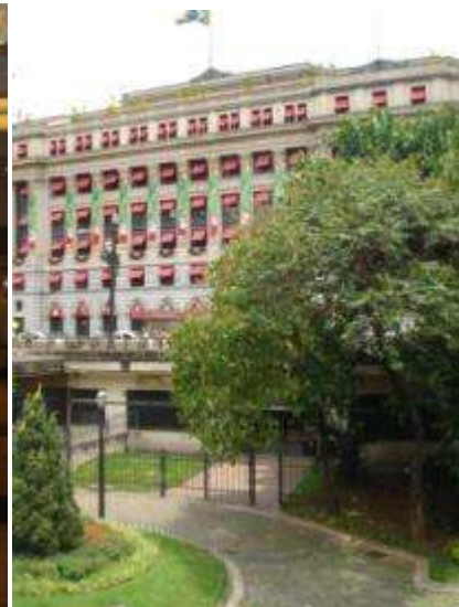
Figura 75- Vista do Viaduto do Chá,
