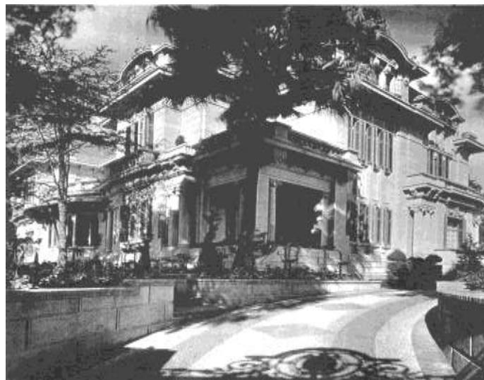
Figura 28- Vista geral do palacete do Dr. Jorge Street
