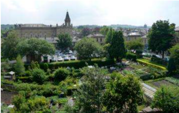
Figura 42- O Victoria hall visto do alto do moinho principal
