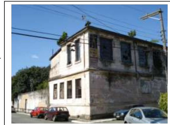
Figura 53- Ao lado, foto atual (2009) da Escola de Meninos. Ruínas.
