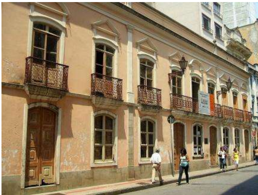
Figura 17- O Solar da Marquesa, no centro de São Paulo, em restauração (Foto: Dornicke Webb, 2009)
