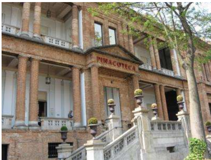
Figura 16 - O prédio atual da Pinacoteca do Estado (Foto: Patricia Webb)
