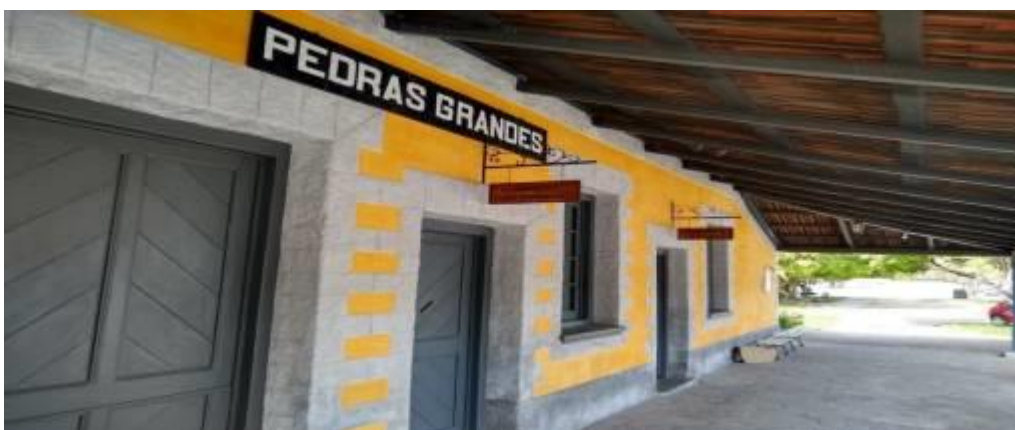
Figura 31: Vista da entrada do prédio que acolhe o Museu Municipal de Pedras Grandes. Fonte: Autor (2020).
