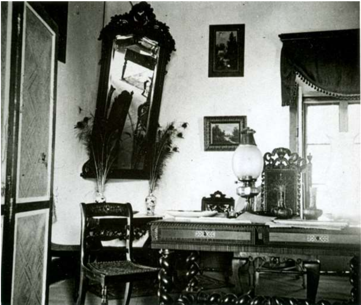
Fotografia XVII – Interior do Edifício do Observatório. Sala de Estar I.
