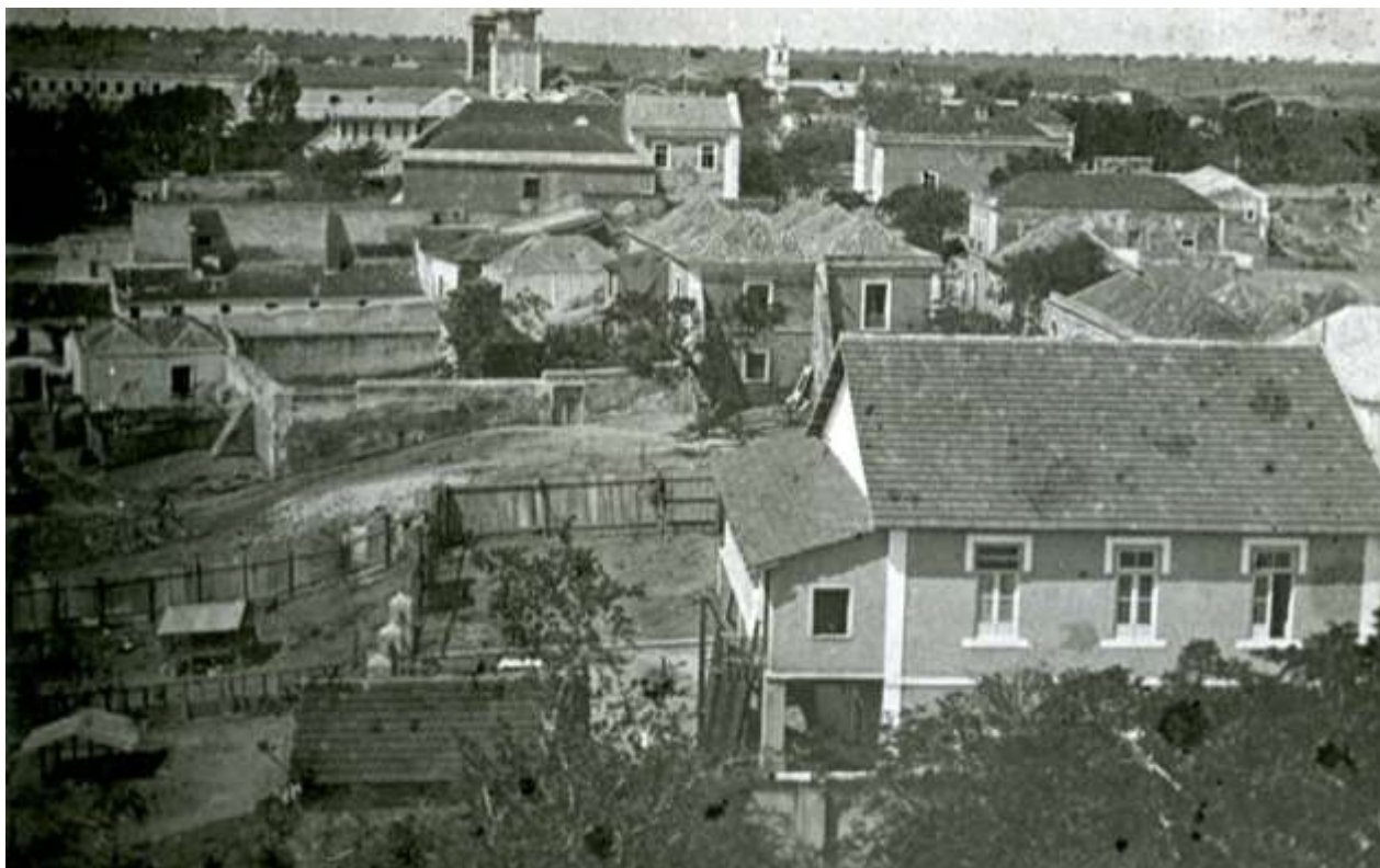
Fotografia IX – Observatório Meteorológico e vistas envolventes. Alta da Cidade.
