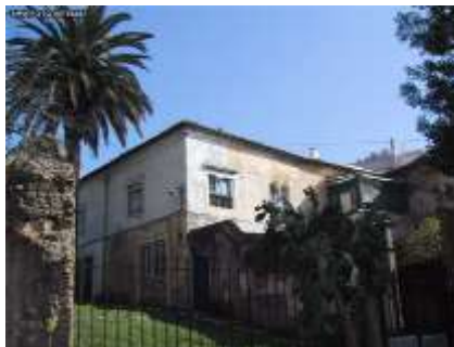
Figura 318. Vila Adelina, Lumiar. Fonte: SIPA, FOTO 00758461
