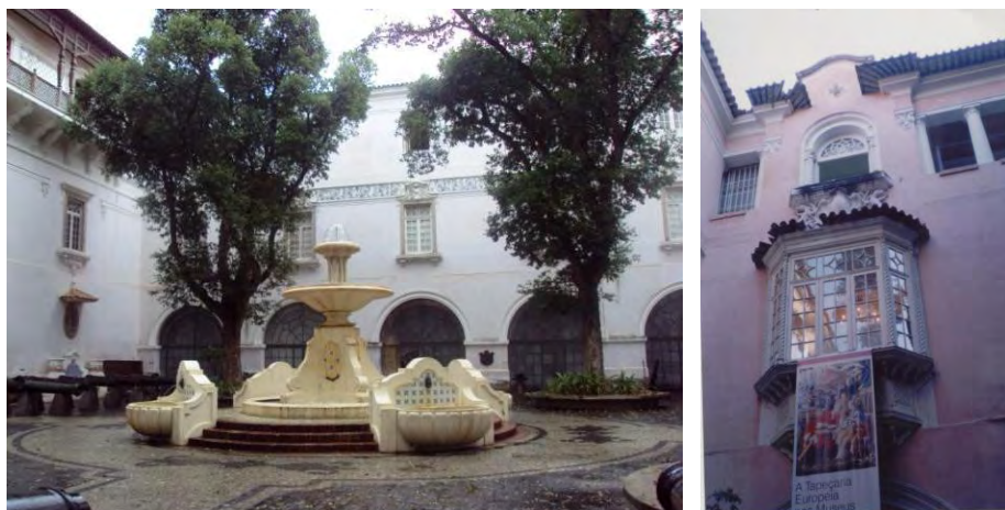
Figuras 83 e 84 - Pátio dos Canhões. Chafariz, 2001. Balcão e fachada interna em cor de rosa pombalino, 2003.
