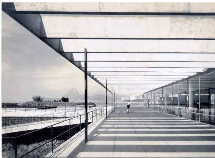
Figura 45 - Terraço com pérgula, MAM-Rio, arquiteto Afonso Eduardo Reidy.
