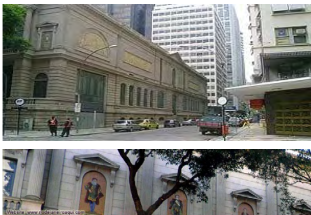
Figuras 115 e 116 - MNBA: Fachada posterior voltada para a rua México. Fachada lateral voltada para a rua Araújo Porto Alegre com painéis de mosaicos.
