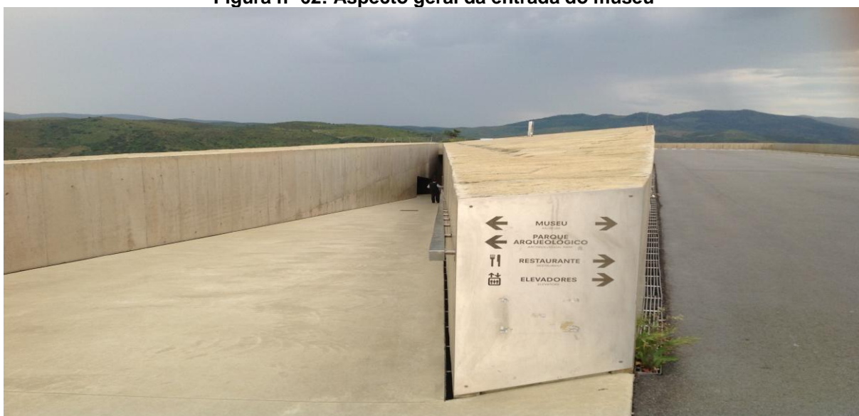
Figura nº 62: Aspecto geral da entrada do museu
