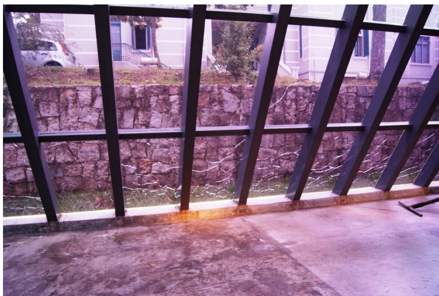
Figura 45 – Fachada de vidro vista por dentro do edifício.
