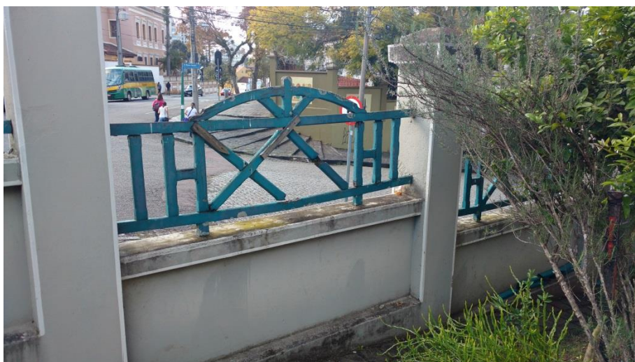
Figura 46 – Muro e grades de madeira.
