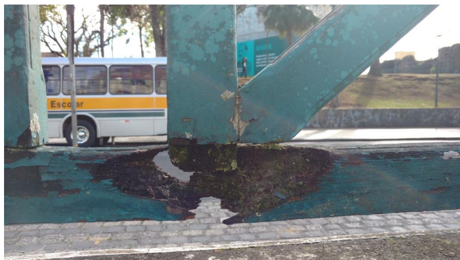
Figura 47 – Detalhe da grade de madeira.
