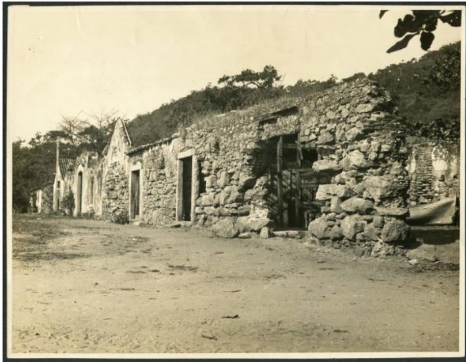
Figura 16 - Ruínas da fachada frontal do Recolhimento, com perdas na estrutura e proa de embarcação à direita. Brasil, sem data.
